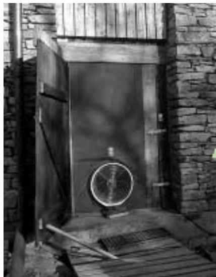
^ Blower door im Einsatz
