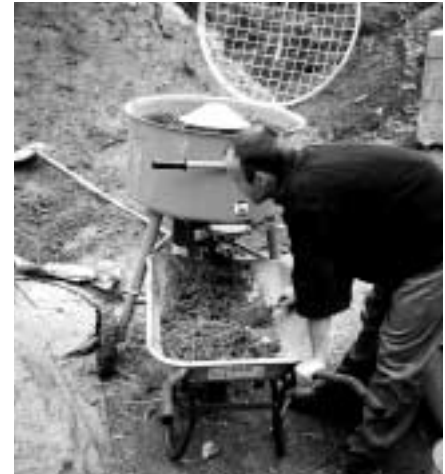
> Erdaushub wird vor Ort zu Leichtlehm-Mischung verarbeitet
