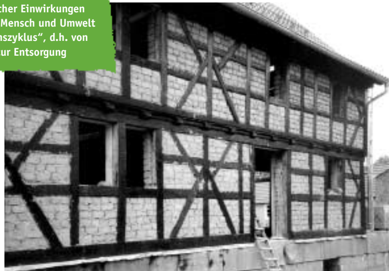
> Fachwerk wird mit Hanf-Leichtlehm-Steinen neu ausgefacht
